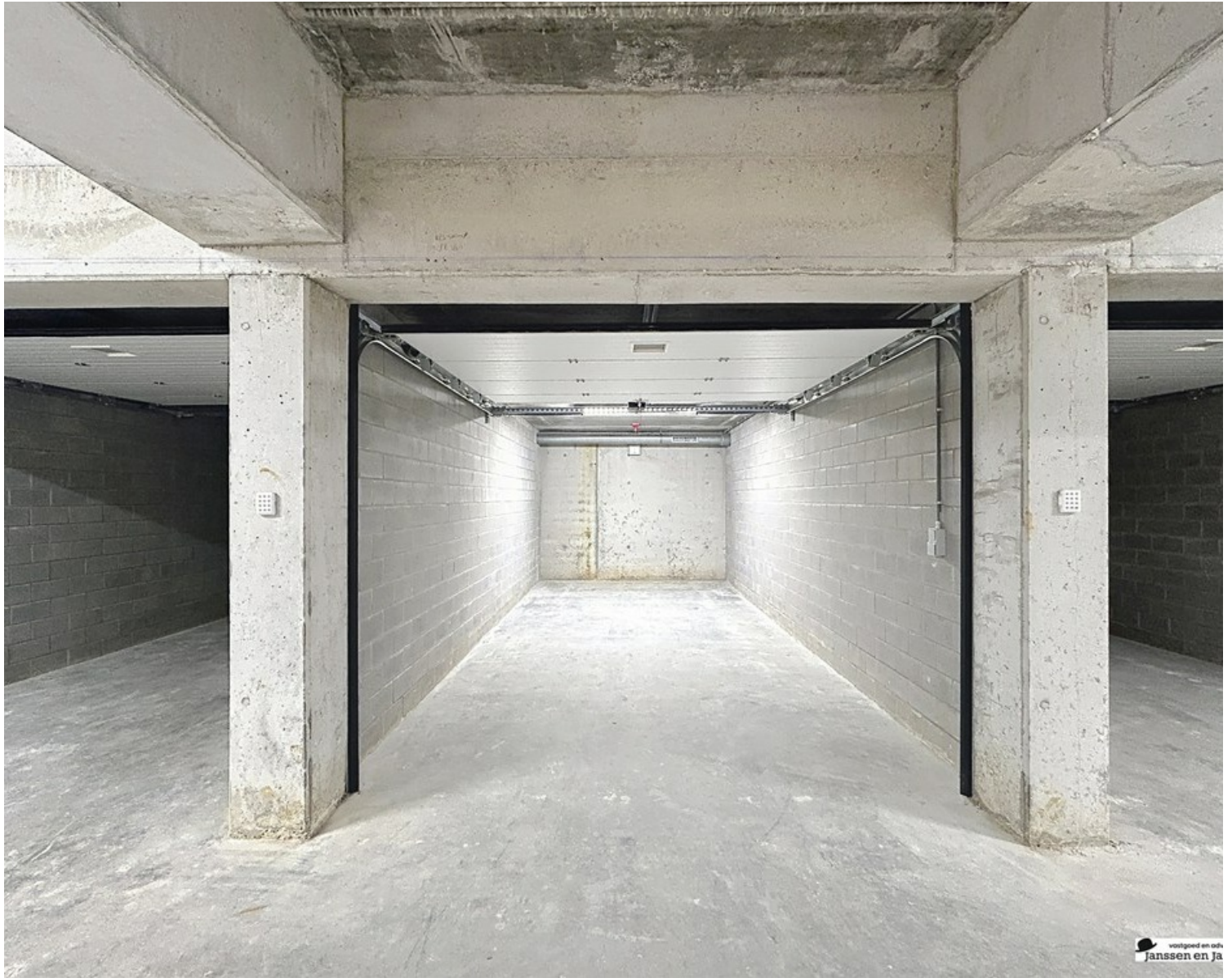
Ondergrondse garageboxen in project Goorbos
